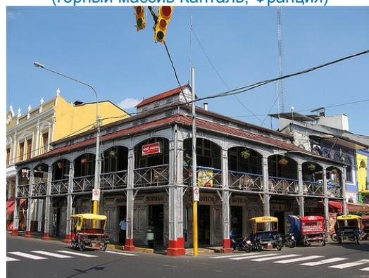
*Гюстав Эйфель разместил заказ на отливку деталей конструкции дома в бельгийских цехах компании Джона Д. Рокфеллера "Standard Oil" (ныне ESSO), подверг их антикоррозийной обработке и отправил все части паромом через Атлантический океан. Современный владелец организовал дом следующим образом: на первом этаже размещаются лавки сувениров, а на втором этаже расположено кафе «Амазонас».*
